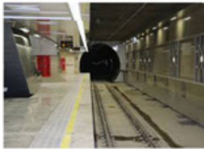
پروژه : ایستگاه 16 قطار شهری تبریز کارفرما : شرکت جهاد توسعه محل پروژه : تبریز
