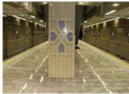
پروژه : ایستگاه 15 قطار شهری تبریز کارفرما : شرکت جهاد توسعه محل پروژه : تبریز
