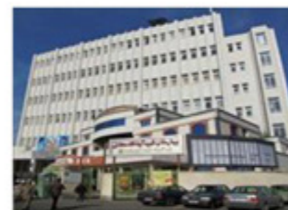
پروژه : بیمارستان شهید محلاتی کارفرما : بیمارستان شهید محلاتی محل پروژه : تبریز
