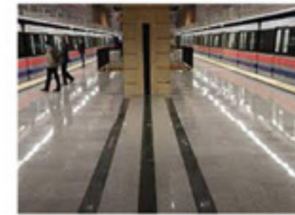
پروژه : ایستگاه 10 قطار شهری تبریز کارفرما : شرکت محل پروژه : تبریز
