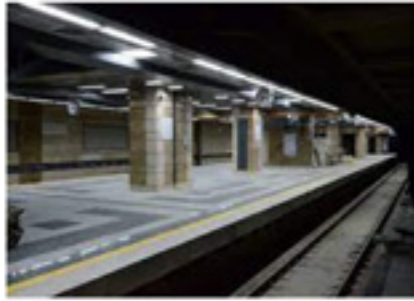
پروژه : ایستگاه 9 قطار شهری تبریز کارفرما : شرکت جهاد توسعه محل پروژه : تبریز
