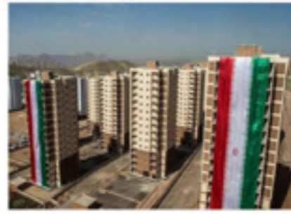
پروژه : برج های برکت کارفرما : شرکت جهاد نصر محل پروژه : زنجان
