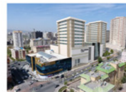
پروژه : مجتمع تجاری پالادیوم کارفرما : شرکت توسعه مسکن آذربایجان محل پروژه : تبریز
