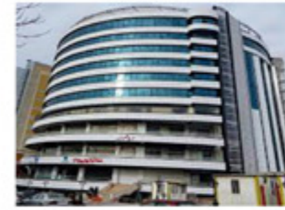
پروژه : مرکز تجاری شهر کارفرما : جناب مهندس عبدلی محل پروژه : تبریز
