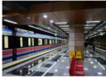
پروژه : ایستگاه 7 قطار شهری تبریز کارفرما : شرکت جهاد توسعه محل پروژه : تبریز
