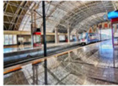
پروژه : ایستگاه 5 قطار شهری تبریز کارفرما : شرکت بتن کاوه محل پروژه : تبریز
