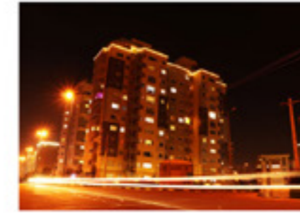
پروژه : برج نیاوران 13 کارفرما : شرکت آخر گالان محل پروژه : تبریز
